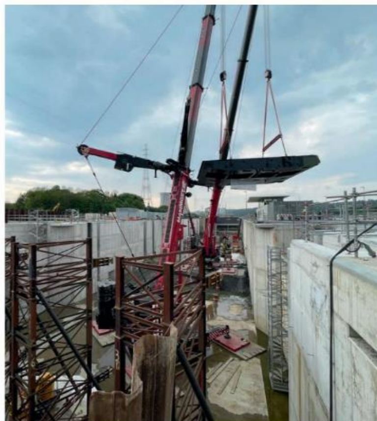
De puntdeuren van de grote sluis (E1) zijn geplaatst met behulp van twee kranen die in de sluis kolk stonden.
