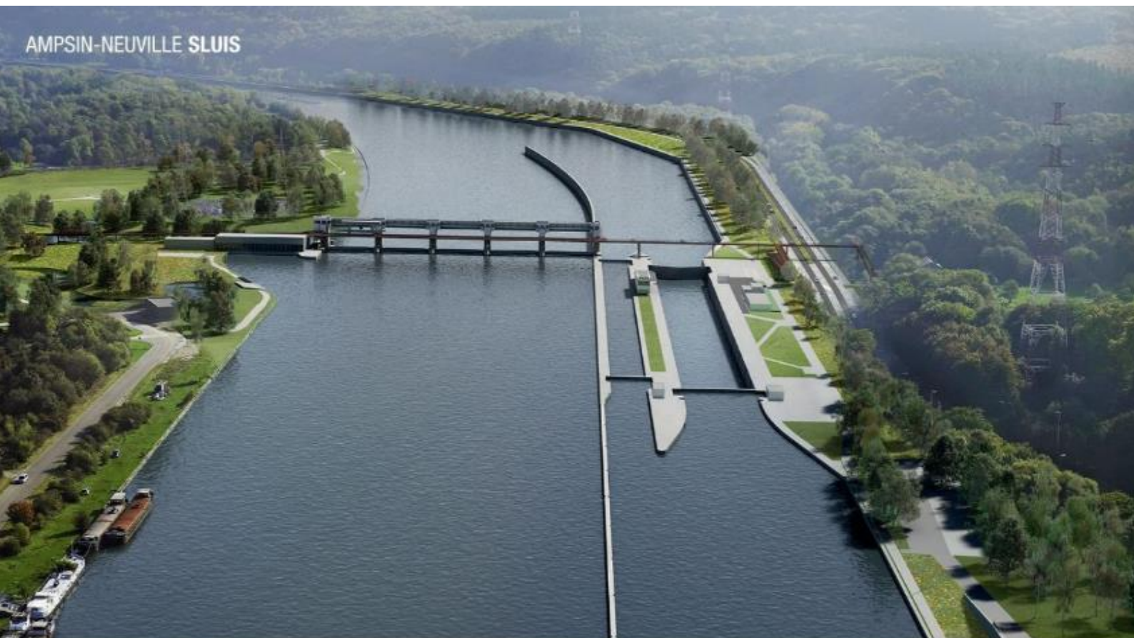
Overzichtsbeeld van de grote en kleine sluis, de passerelle in cortenstaal, de technische gebouwen en de borstweringen. (Beeld: SOFICO)
