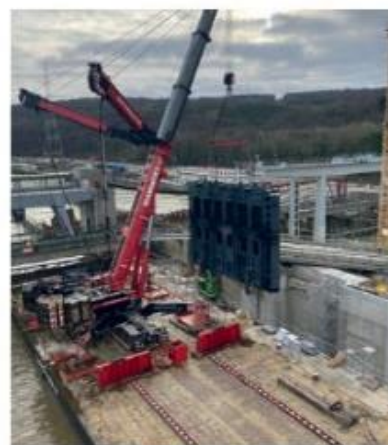
De deuren van sluis E2 werden geplaatst door middel van een kraan op een ponton, wat ongebruikelijk is.
