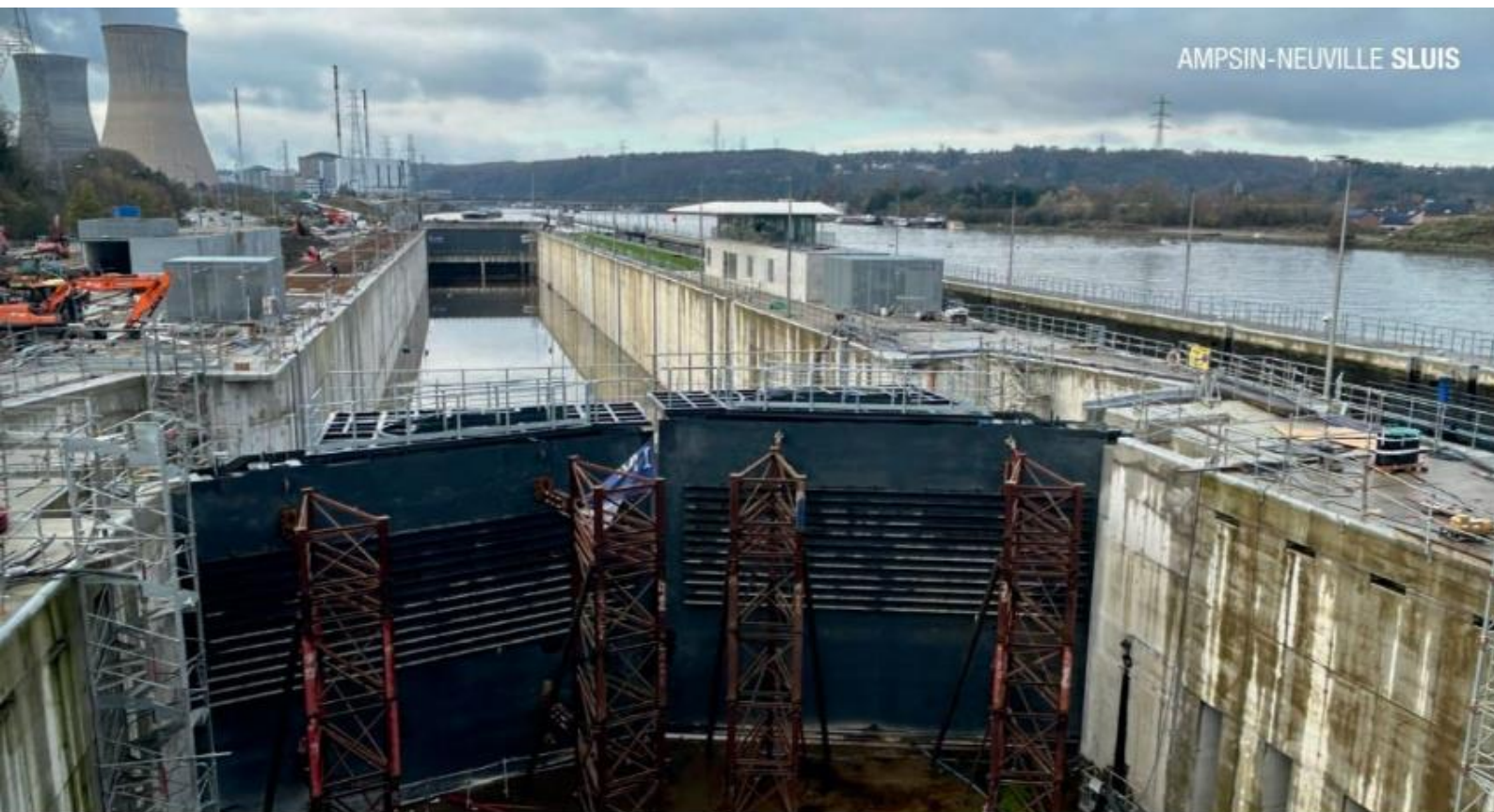
Het bedieningsgebouw, de 'controletoren' van de site, met op de voorgrond een van de twee puntdeuren.
