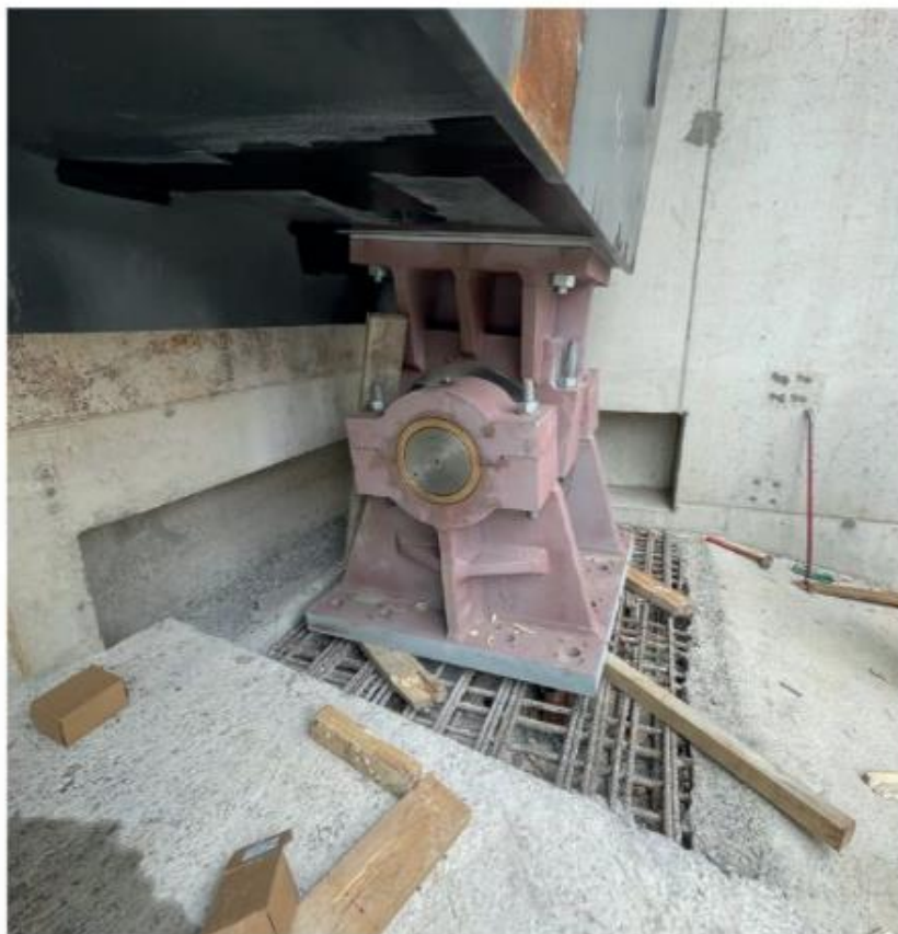
De mechanisch gelaste onderdelen voor de scharnieren werden integraal gerealiseerd door TMI.
