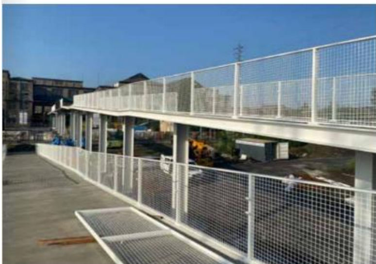
La fabrication des garde-corps suivant les souhaits de l'architecte a donné du fil à retordre.
