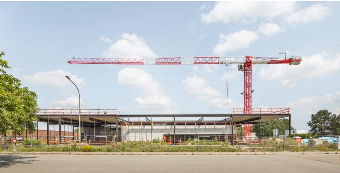
In het Kwartier Majoor Housiau in Peutie verrijst een nieuw horecagebouw voor de gekazerneerde militairen en hun gasten. (MODULO architects, beeld: Corentin Haubruge)
