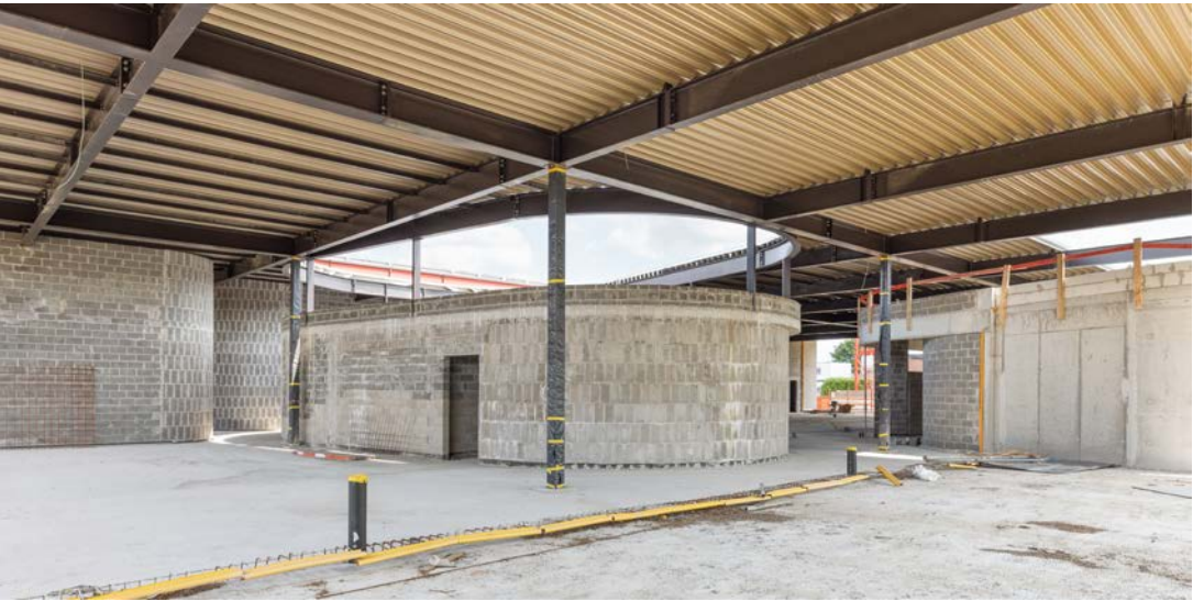
Het gebouw kreeg een hybride structuur in staal, ter plaatse gestort beton en metselwerk. (MODULO architects, beeld: Corentin Haubruge)
