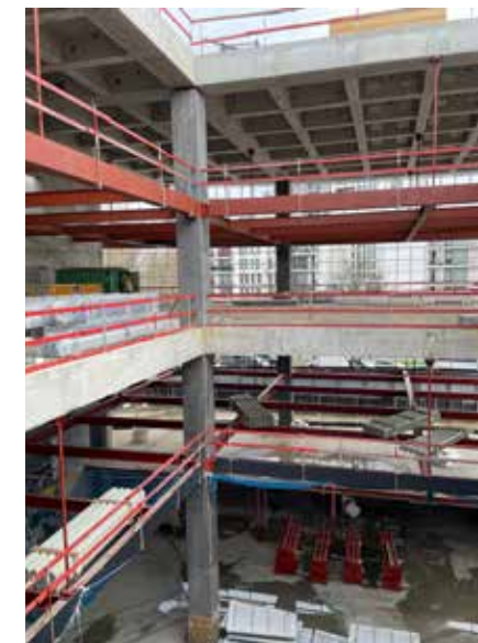
Niveaus +2 en +4 bestaan uit een betonstructuur en niveaus +1 en +3 uit staalprofielen.
