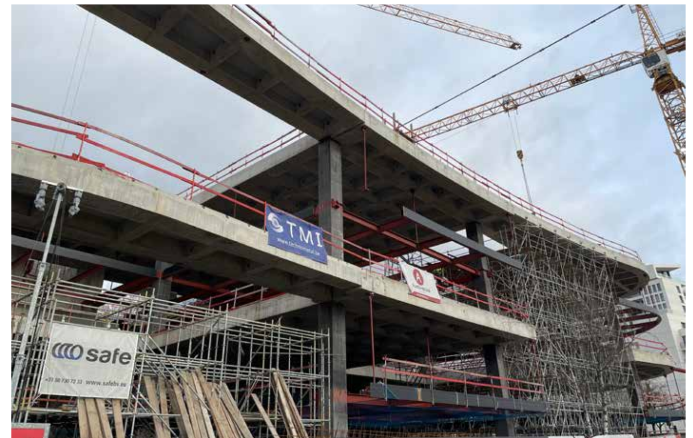
Het Mobilis-project is deze dagen volop in aanbouw.
